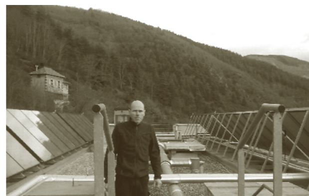
— SOLAIRE THERMIQUE | maison de retraite de St Martin de Valamas - Emmanuel Karbowy
